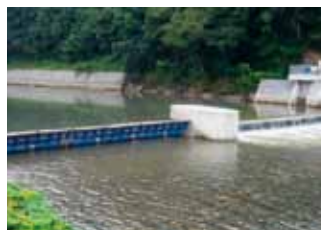
白杉川 起伏ゲート
