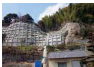
災害復旧現場
