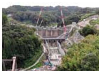
玉来ダム建設風景
