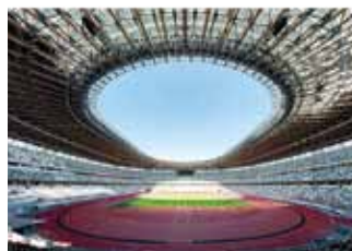
工事実績 (国立競技場)
