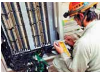
結線作業の様子
