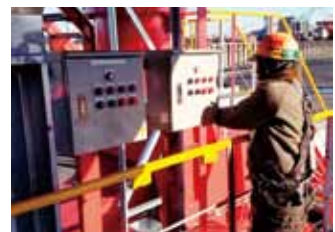
電気品取付作業
