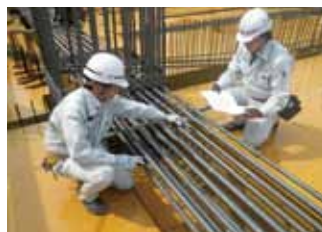
鉄筋圧接部の計測
