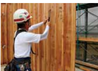
型枠組立て作業状況
