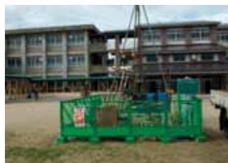
現場作業の一場面
