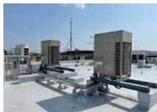
空調・電気工事
