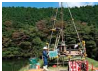
現場作業の一場面
