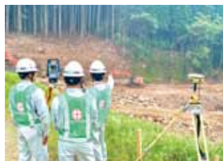
ため池工事 ICT
