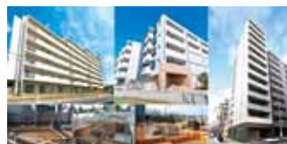
施工中の現場状況（下）、完成物件（上・右）
