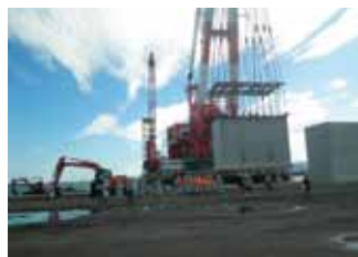
ケーソン製作と据付
