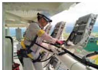
電気工事の様子
