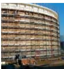
タンク補修工事の様子
