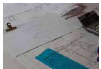
型枠を加工する為の寸法の拾い出し作業
