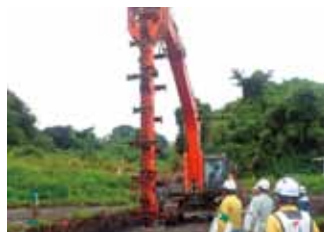
現場での検査風景
