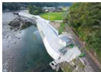
災害で壊れた山国川の護岸を強く、美しく復活させました。
