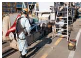
電線管取付作業
