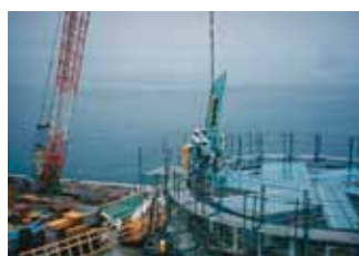
ガラス施工写真
