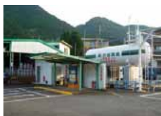
LPガス充填所
