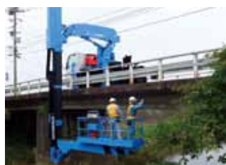
橋梁点検の様子
