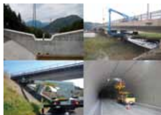
点検作業の様子
