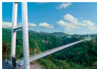
九重“夢”大吊橋
