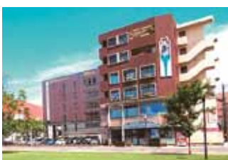
本社ビル (ホルトホール横)
