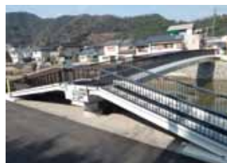
橋や水門の設置工事も行っています。
