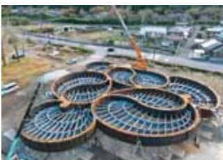
麻布台ヒルズ アリーナ 大屋根 「The Cloud」仮組状況
