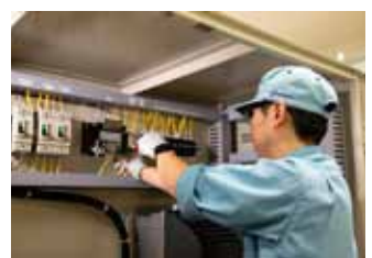
制御盤配線業務作業風景
