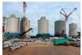
北陸電力(株)七尾、太田火力発電所 バイオマス貯蔵サイロ据付工事
